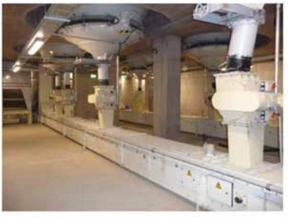
Keller unter Vorratssilos für Rohstoffe
