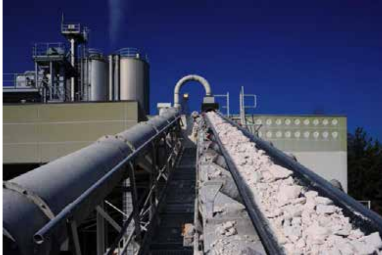
Rohstoffzufuhr – bereits vorgebrochen
